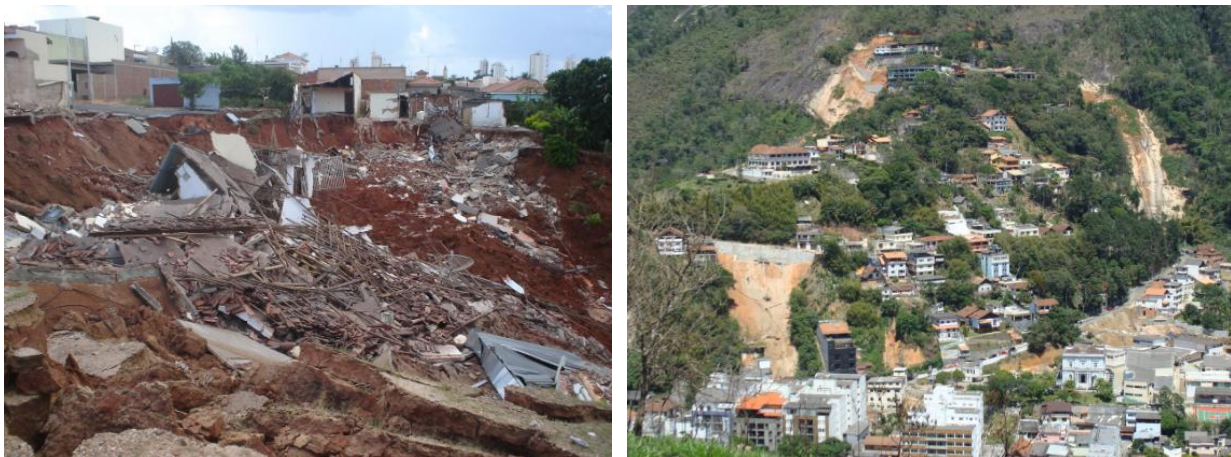
Figura 4. Imágenes de erosión y deslizamiento de cuevas en áreas urbanas en el Brasil. Fuente: Lorandi, 2013.
